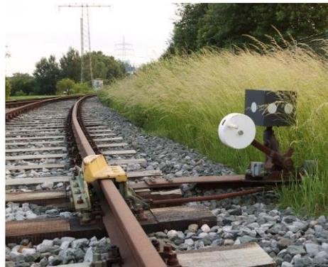
Der Montageort der Gleissperre sollte abhängig von den örtlichen Gegebenheiten und dem Ergebnis der Risikobewertung gewählt werden. Idealerweise wird ein Gleis
